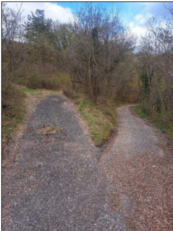
FOTO 01: diramazione stradale, presa da est.
