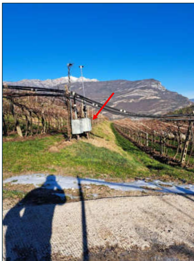
FOTO 46: confine est della p.f. 5070/1 con evidenza della centrale irrigua del consorzio – presa da sud.
